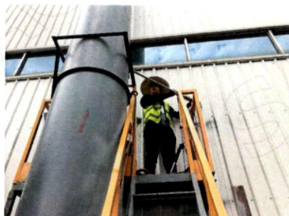
喷砂工序废气处理后排放口 2#
